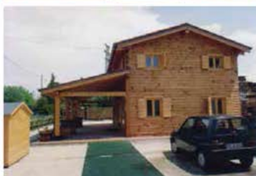
La casa in legno montata nel piazzale di I.L.L.E.A. negli anni '90
